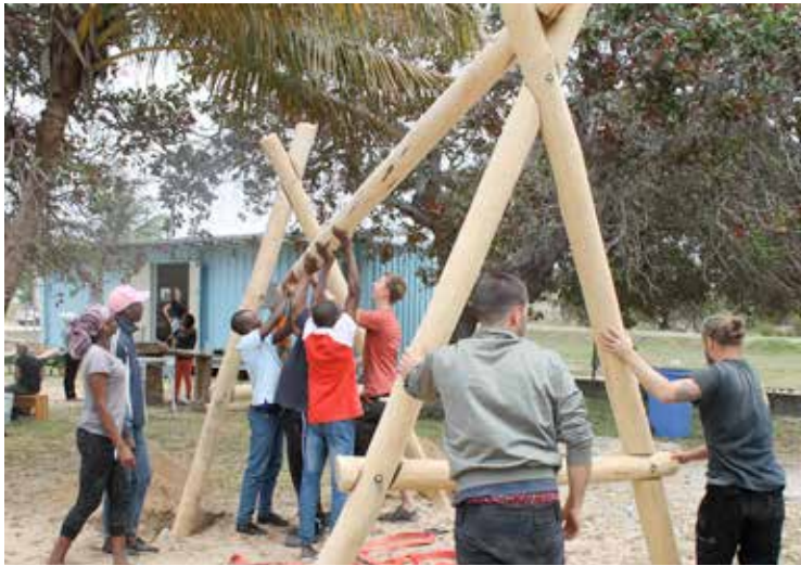
ZUSAMMENBAU DER EINZELNEN ELEMENTE DES SPIELPLATZES
