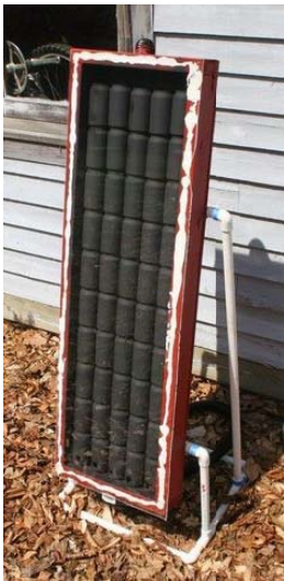
Solarthermieanlage für warmes Brauchwasser durch upcycling von Weißblechdosen
