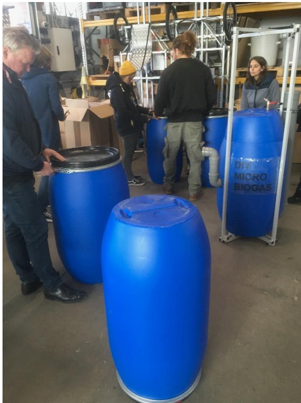
Abb. 50 Bau der Biogasanlage Foto: Thomas Mönkemeyer
